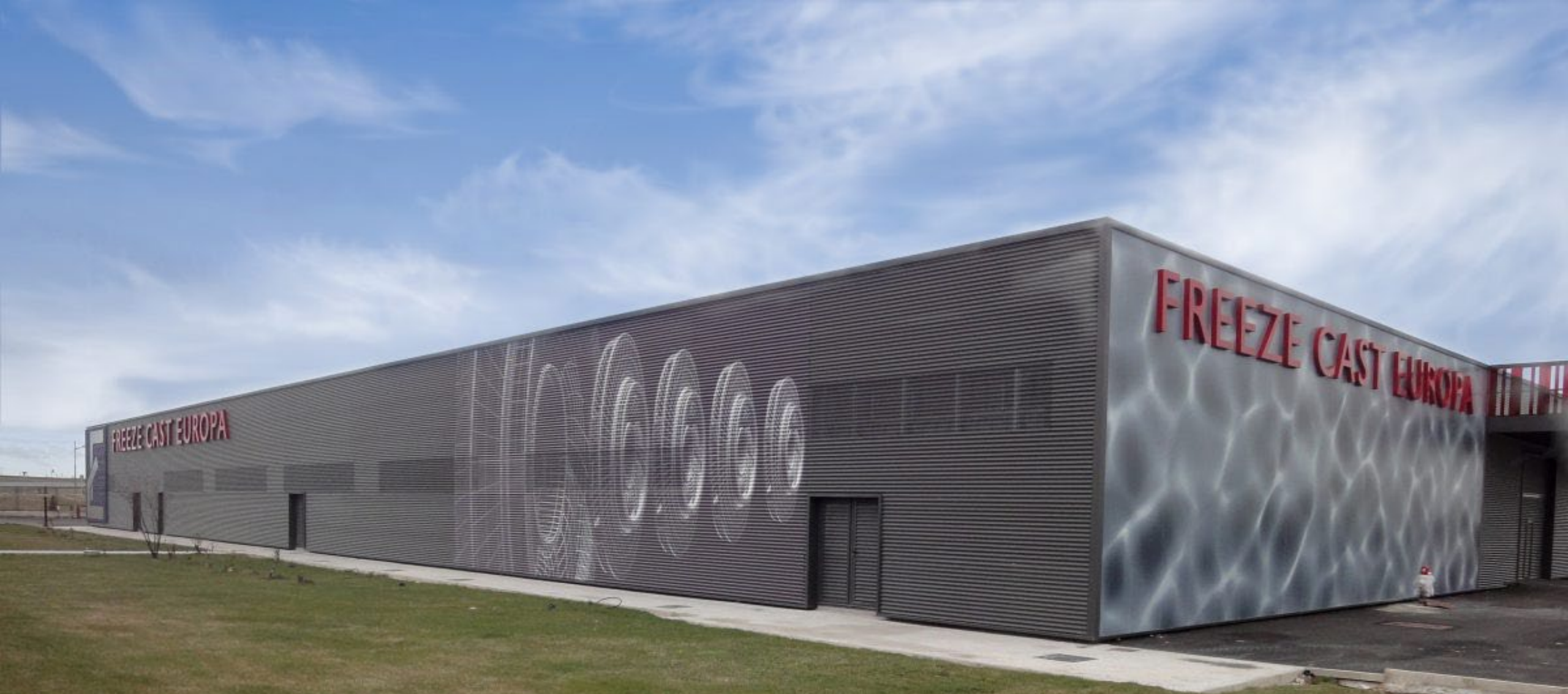
PANEL SANDWICH GALATEA 50 , PERFIL MINIONDA CON Y SIN PERFORACIÓN NAVE INDUSTRIAL FREEZE CAST EUROPA (VALVERDE DE MAJANO, SEGOVIA)
